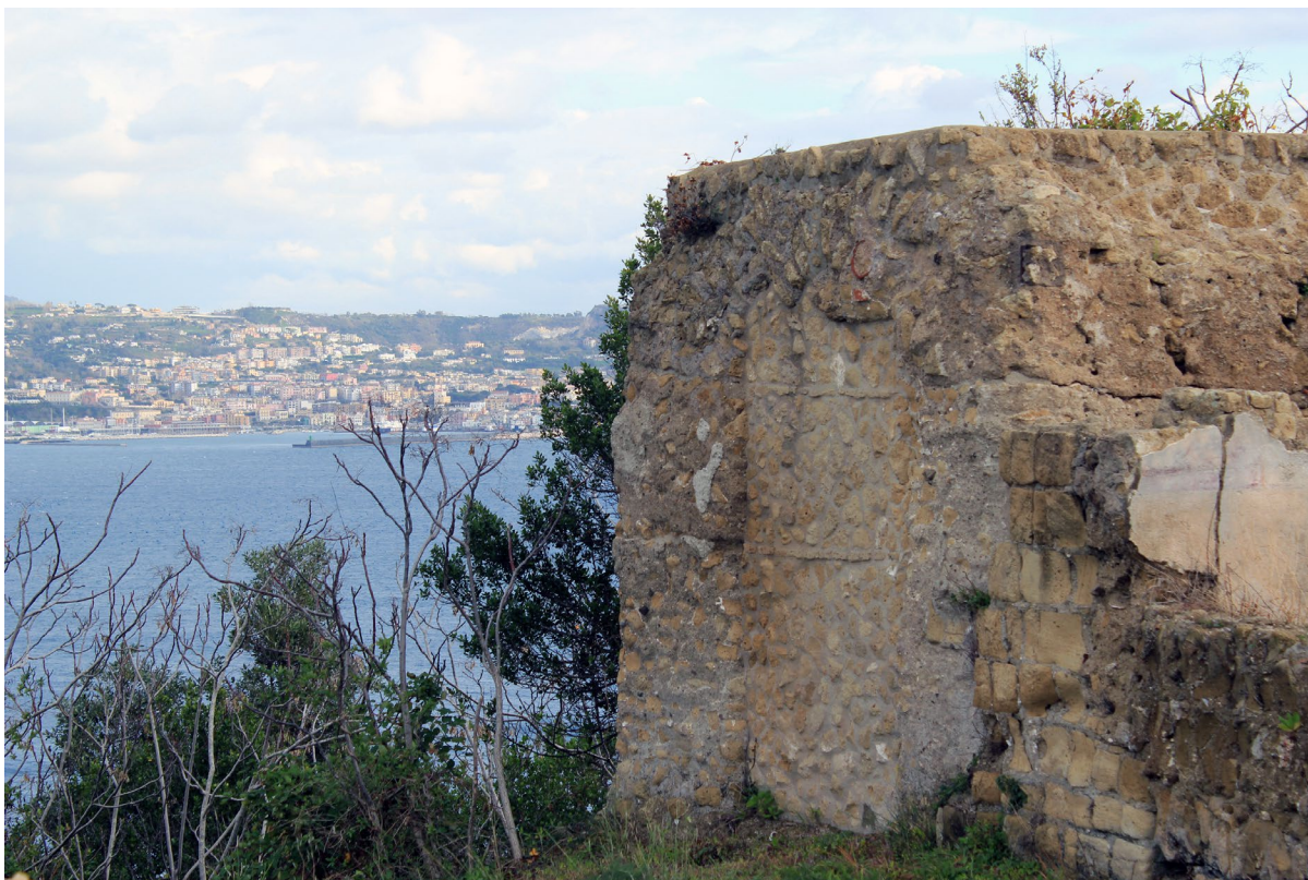
Figure 6 - Strutture archeologiche della villa romana del II sec aC e vista panoramica
