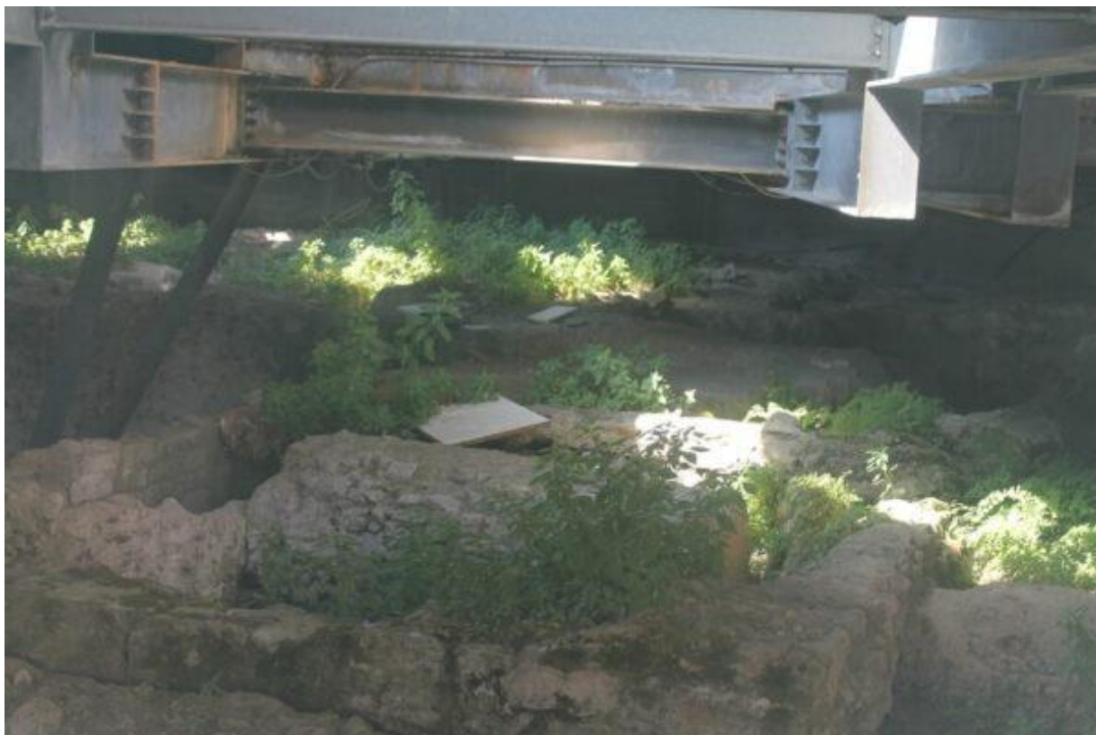
Figura 6 – Vista delle strutture ipogee
