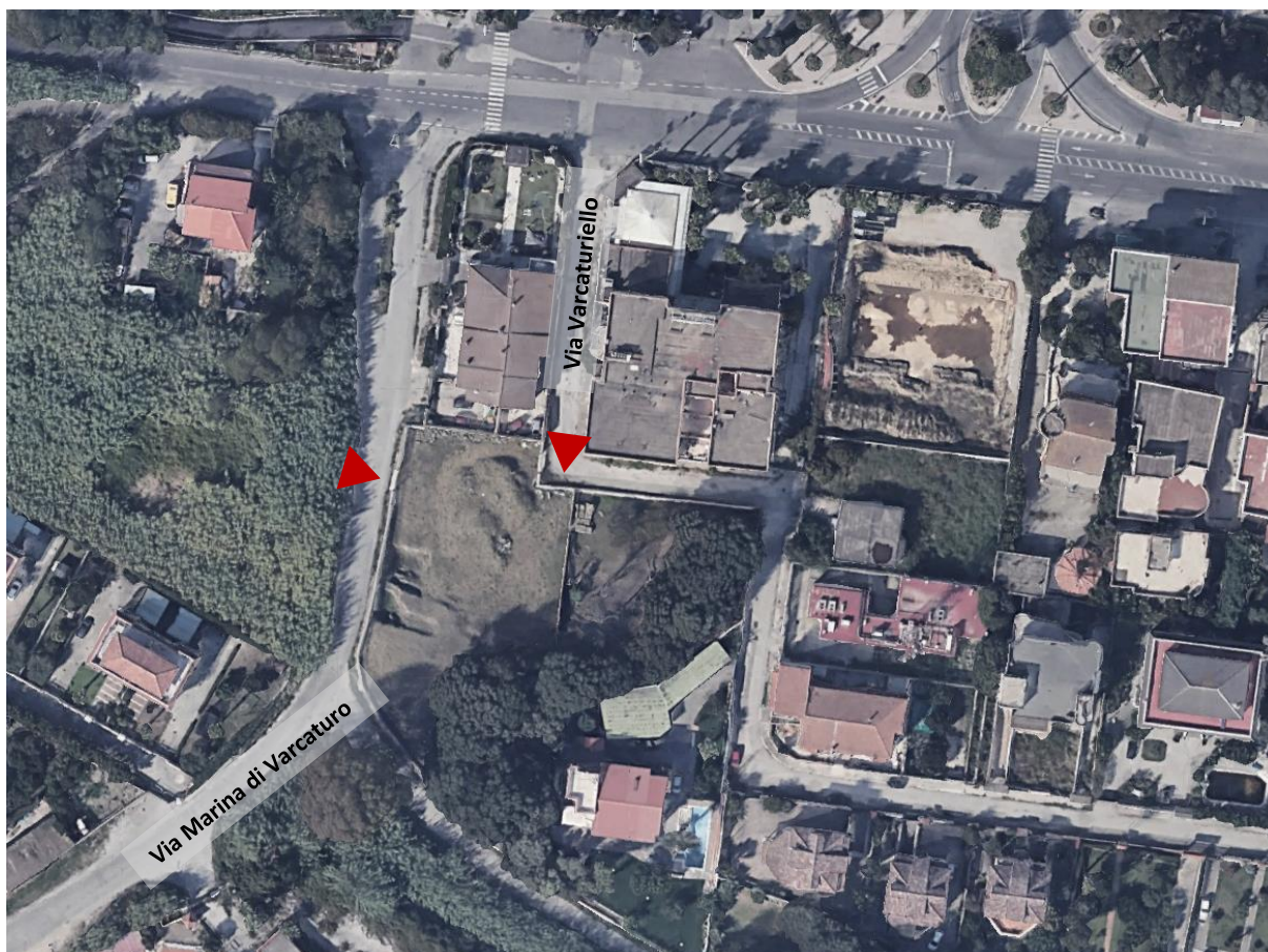
Figura 9 - Foto aerea con indicazione degli accessi
