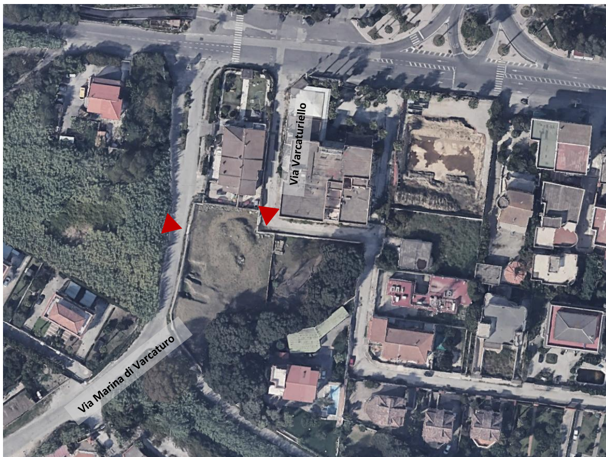
Figura 8 - Foto aerea con indicazione degli accessi
