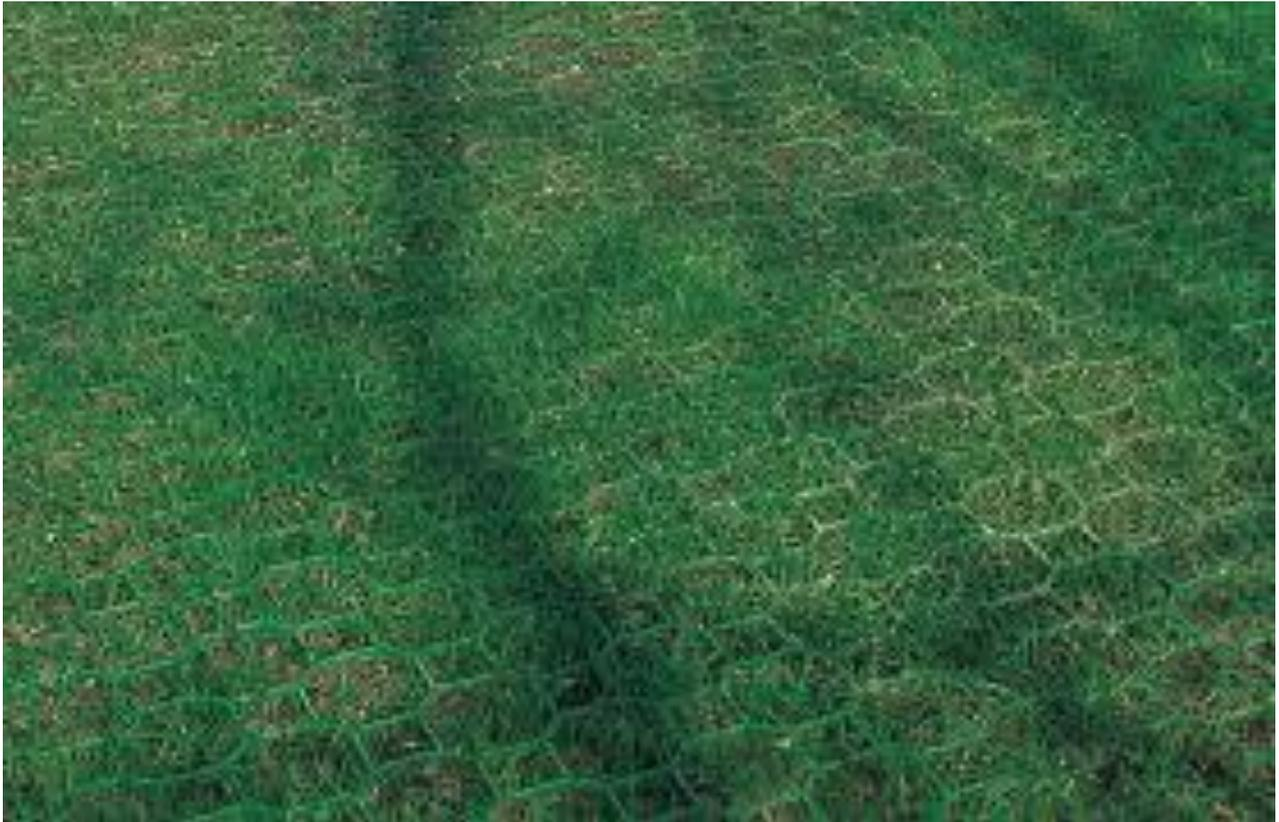
*Figure 14 - Percorso inerbito con elementi in polipropilene ad alta densità*
