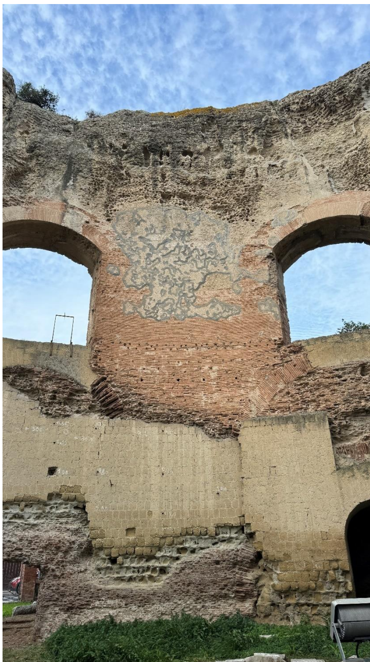
Figura 7 – Vista interna Fotografia febbraio 2024
