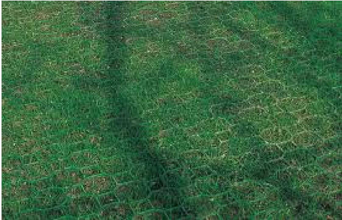
*Figura 23 - Percorso inerbito con elementi in polipropilene ad alta densità*
