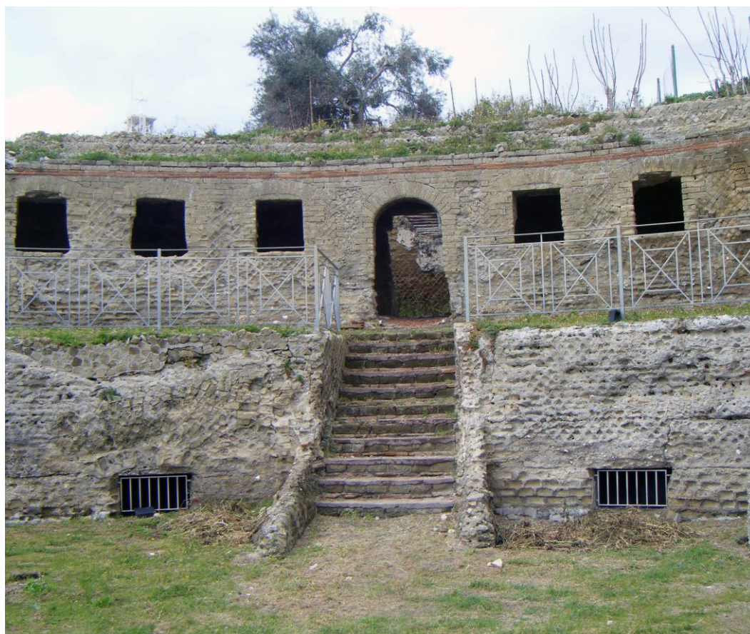
Figura 6 - Scala in muratura, accesso all'ambulacro mediano
