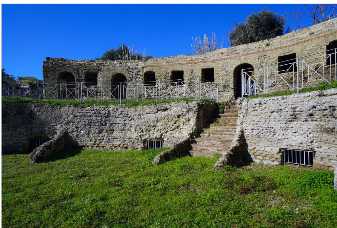
Figura 5 – Scala in muratura, accesso all'ambulacro mediano
