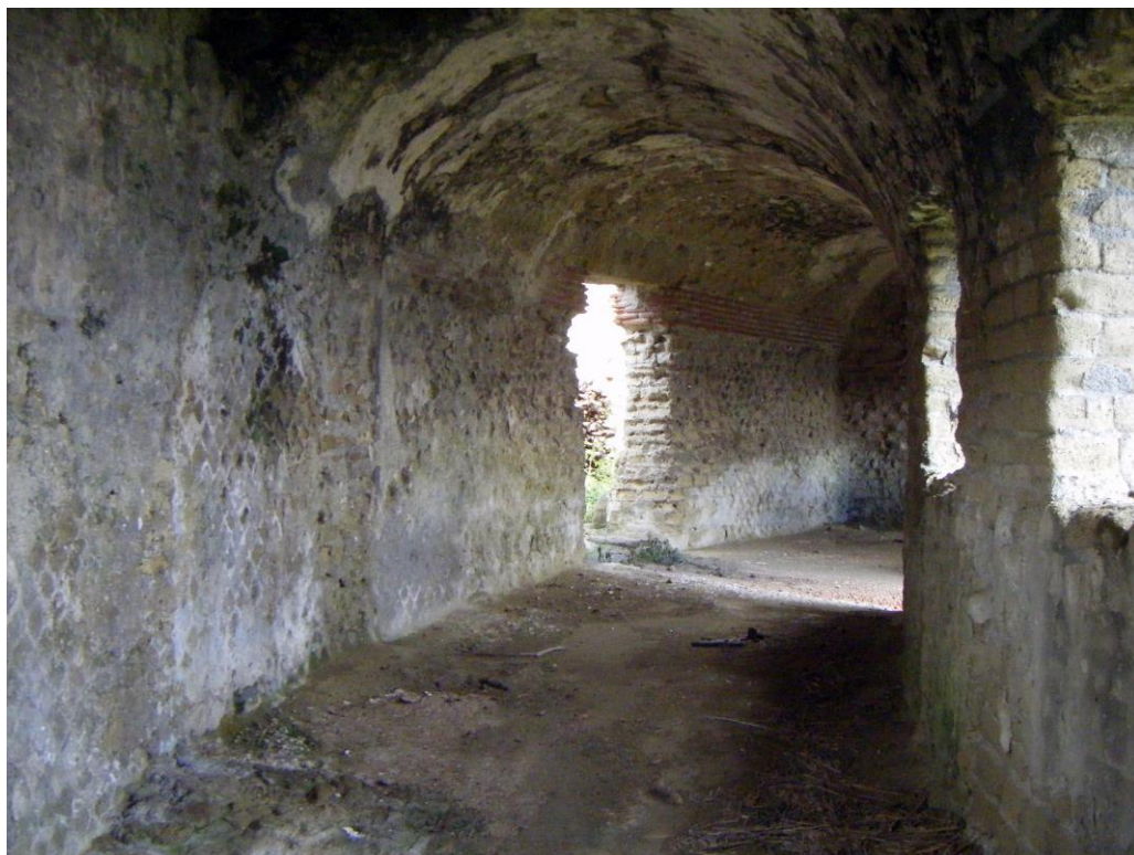
Figura 8 – Ambulacro mediano coperto con volta a botte
