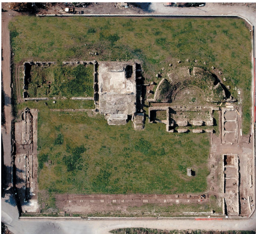
Figura 4 - Vista dall'alto delle strutture - da sx: Basilica, Capitolium, Odeion; in basso il Foro
