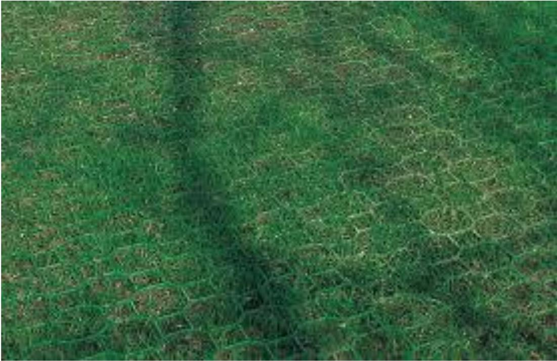
Figura 11 - Percorso inerbito con elementi in polipropilene ad alta densità
