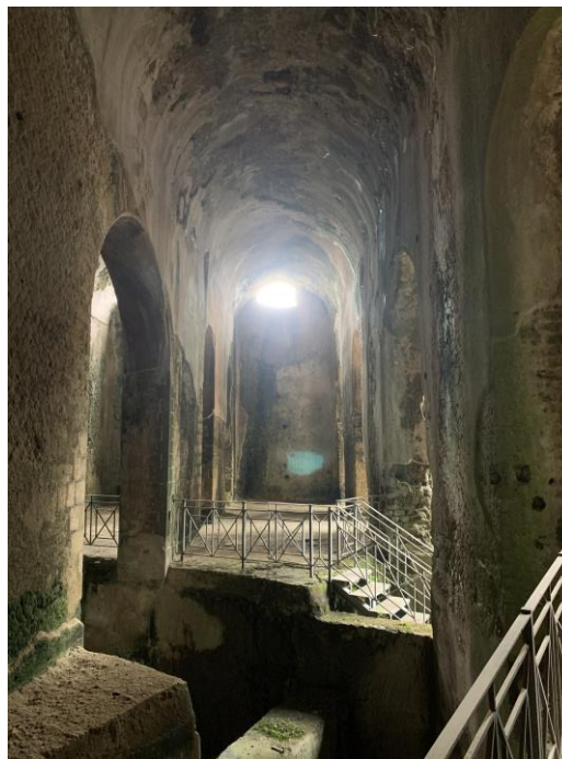
Figura 6 - Vista della navata della cisterna
