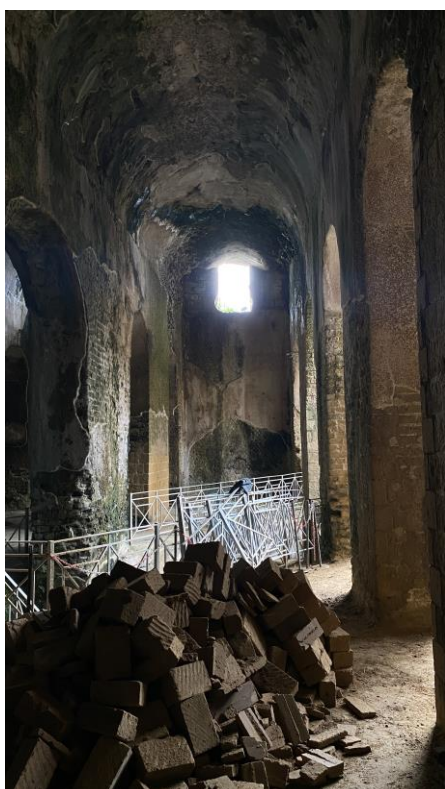
Figura 7 - Vista della navata della cisterna
