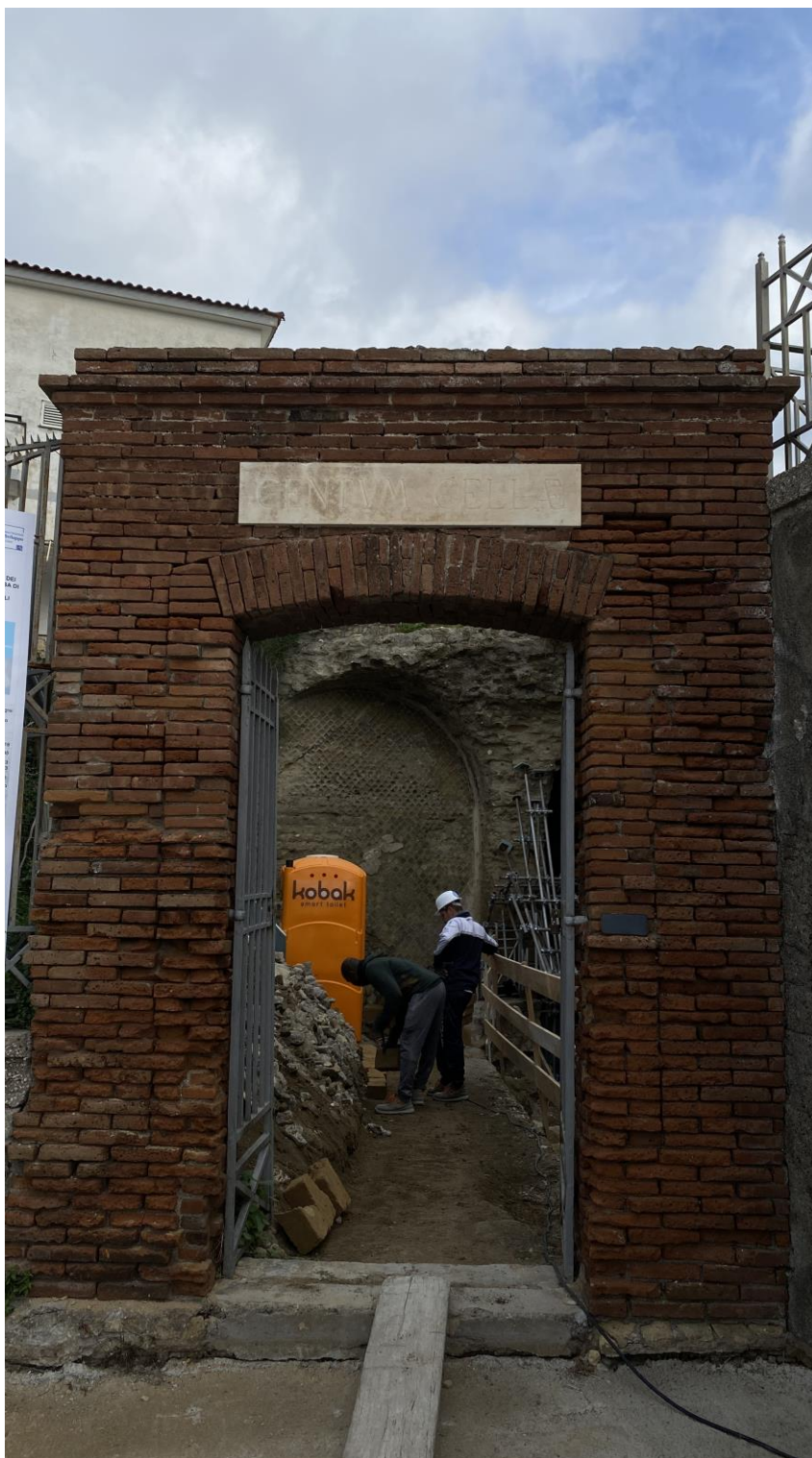
Figura 4 - Accesso al sito da via Centro Camerelle (foto 2024 – cantiere in corso di esecuzione)
