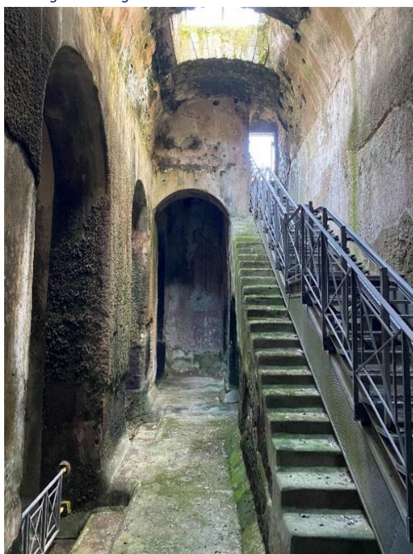
Figura 4 – Ingresso sud (con scala metallica)
