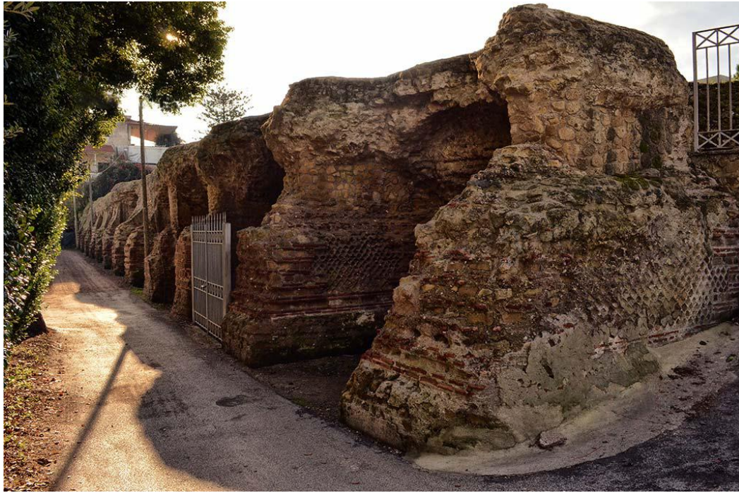
Figura 12 – Fronte est (foto 2022)
