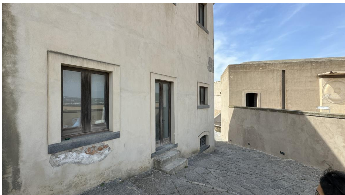
Figura 9 – Ingresso ai locali adiacenti alla Chiesa
