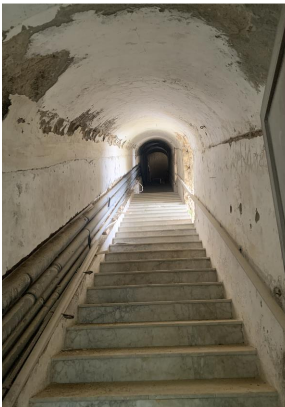
Figura 19 – Scala di collegamento tra la Torre di Mezzaluna e il Piazzale Vittorio Veneto
