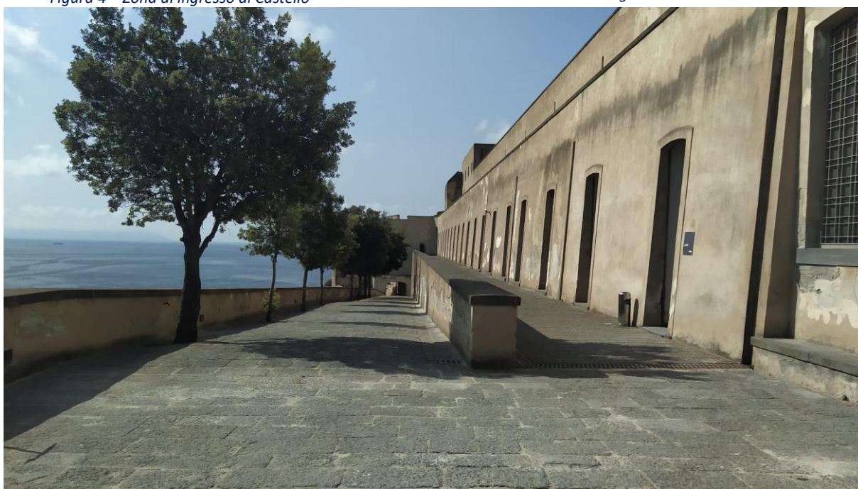
Figura 6 – Rampe IV Novembre
