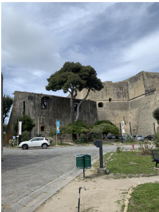
Figura 4 – Zona di ingresso al Castello
