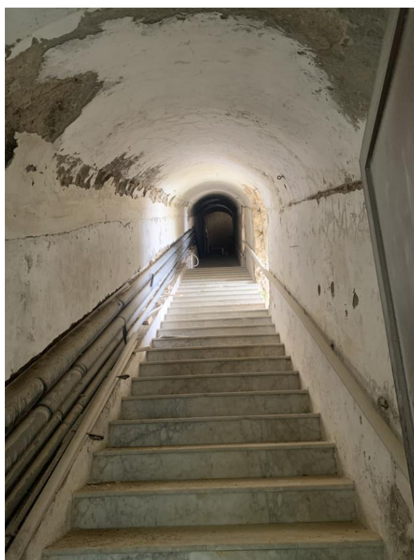
Figura 11 – Scala di collegamento tra la Torre di Mezzaluna e il Piazzale Vittorio Veneto
